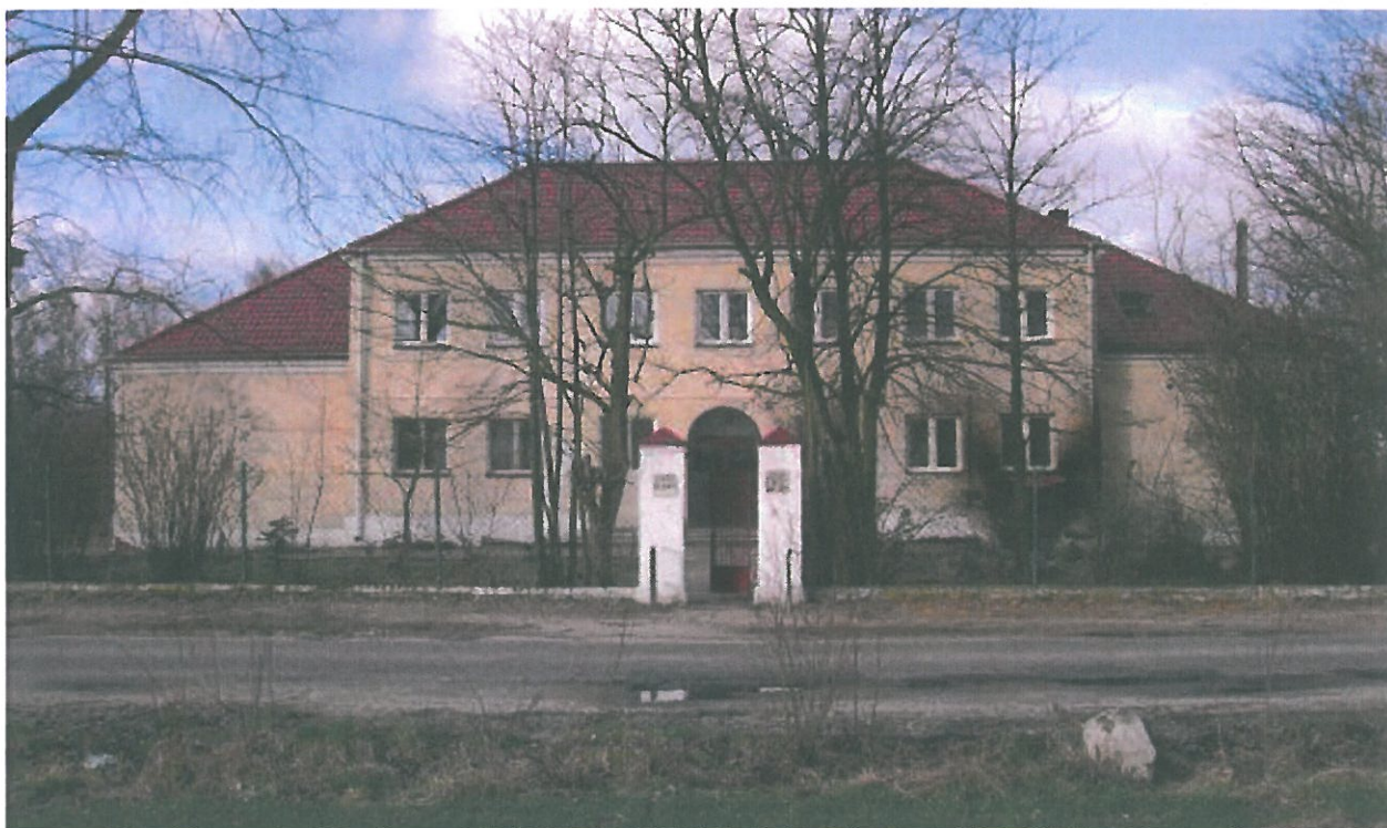
Rys. 3. Elewacja frontowa budynku
