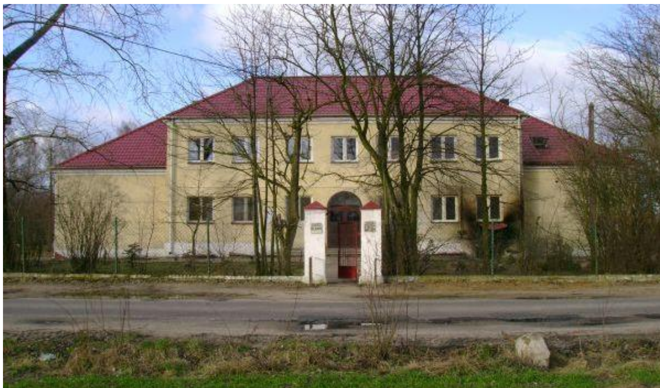
Rys. 3. Elewacja frontowa budynku
