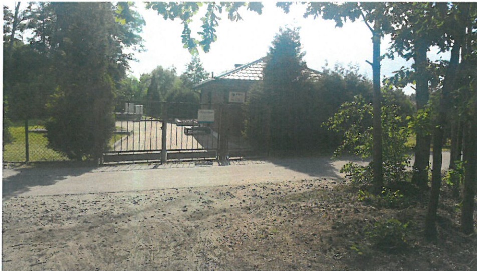
Fot. 1. Przepompownia ścieków na działce o nr ew. 202/15.
