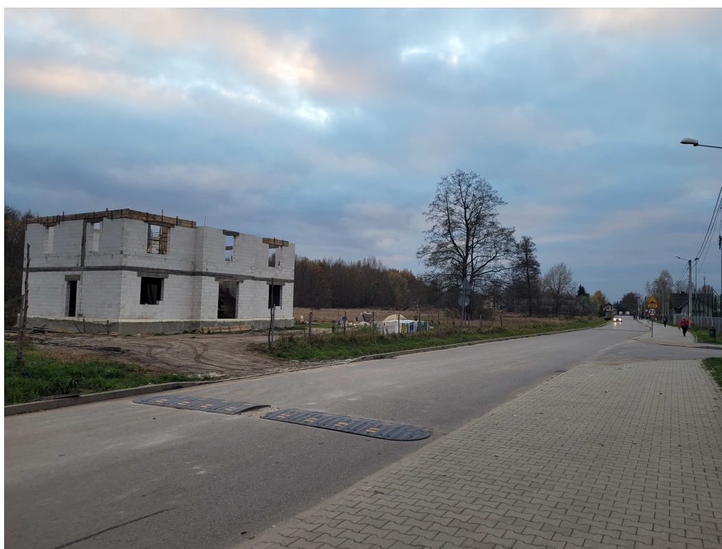
Fot. 2 Widok w kierunku ul. Ogrodowej.
