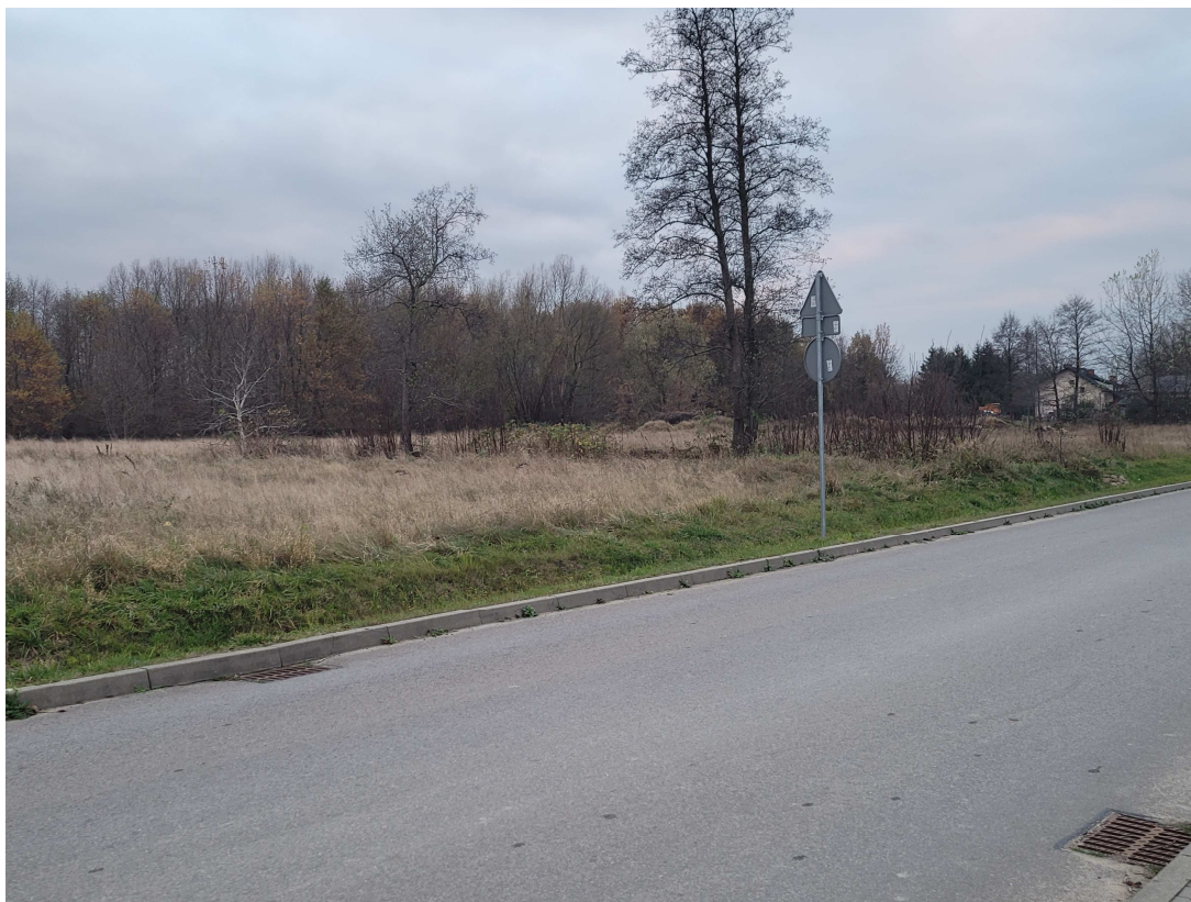
Fot. 3 Widok w kierunku ul. Ogrodowej.
