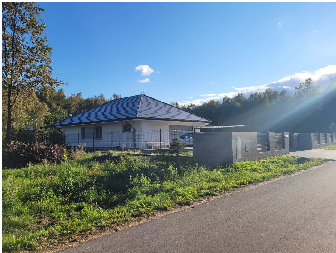
Fot. 4 Widok od ul. Słonecznej.
